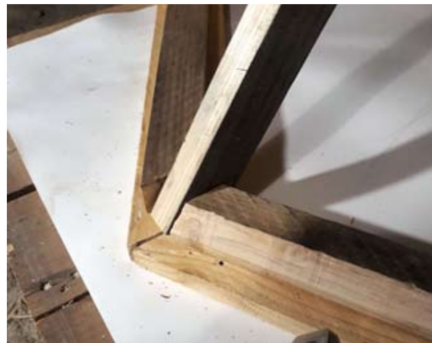
Détail d'assemblage en bas du chapeau Découpe des tasseaux pour assemblage en bas
