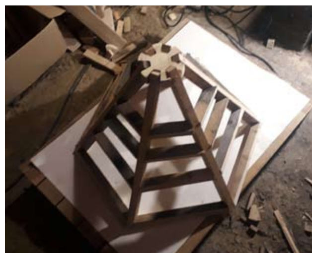
Ajout des tasseaux de fixation des planchettes entre les tasseaux de structure. Ca serait beaucoup plus simple de fixer des lattes ou liteaux par dessus les tasseaux de la structure comme recommander sur le dessin.
